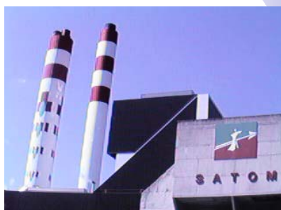
Usines d'incinération d'ordures ménagères
